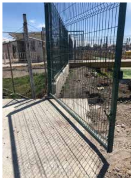
Avances de mantenimiento a cerca perimetral.
