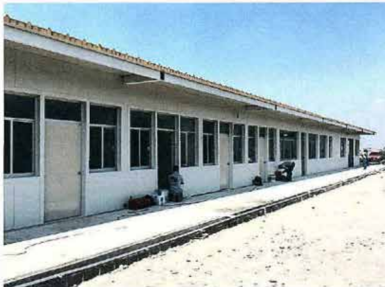
Parte de la Obra de Aulas Ligeras Dos, Laboratorios.
