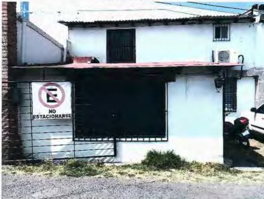
Nuevo espacio arrendado en 2016. Av. Hidalgo Pte. 44, bodega
