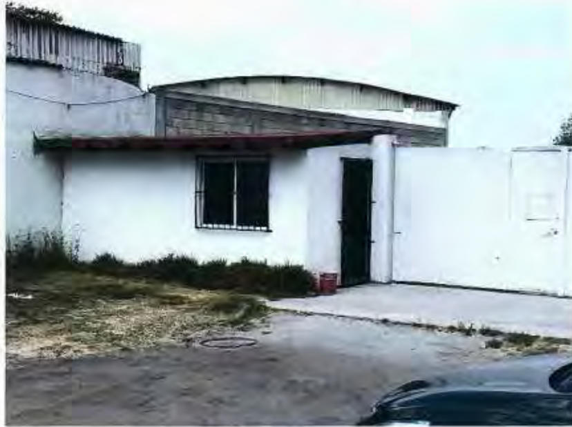
Nuevo espacio arrendado en 2016. Av. Hidalgo Pte 44, almacén
